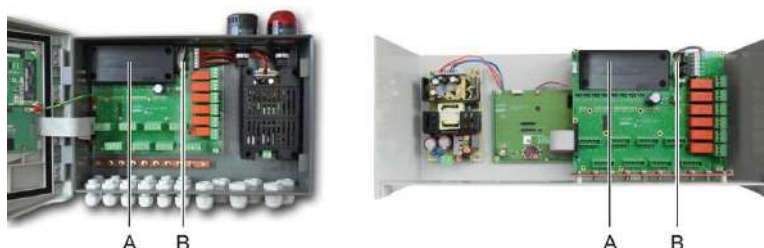
Figure 30 : mise en place du pack batterie.
